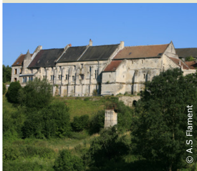
Ferme fortifiée à Ressons-le-long
