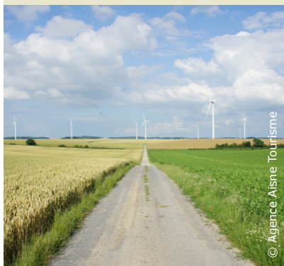
Le parc éolien de Lislet
