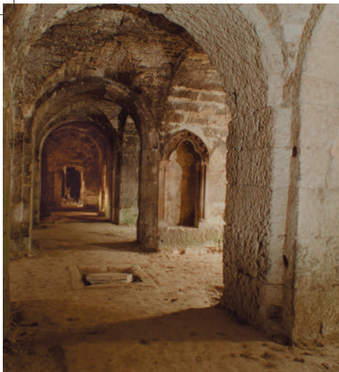
Le couloir principal de la crypte Saint-Médard dessert les chapelles ayant abrité les tombeaux royaux.
